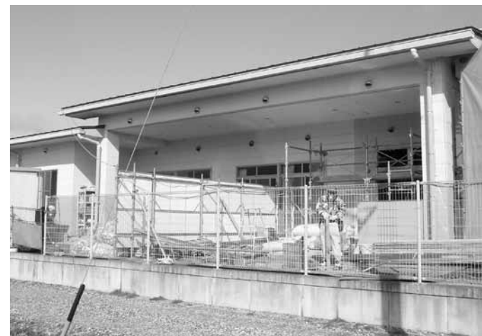
増改築工事現場
