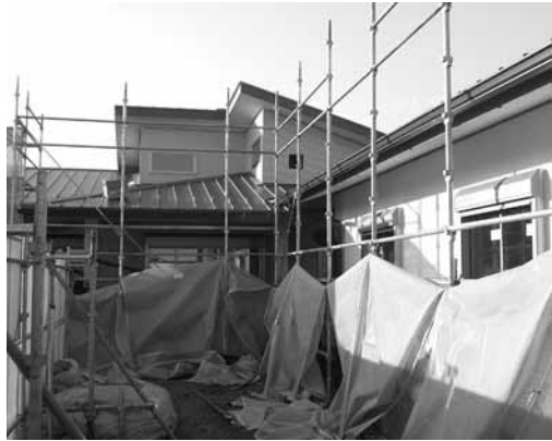
建設中のグループホーム
