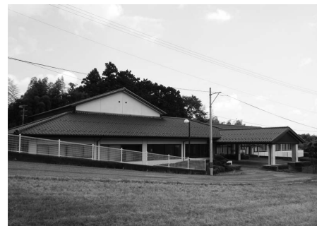
改修予定の地域福祉センター（若宮地内）
