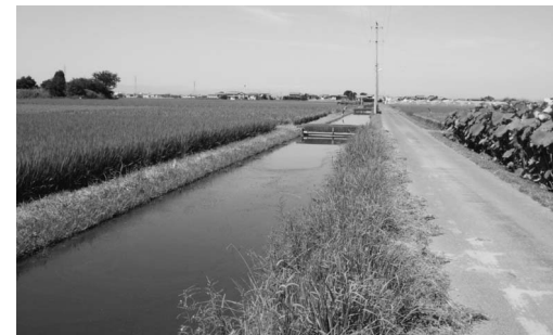
基盤整備場内の通学路
