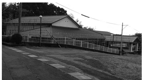
改修中の地域福祉センター
