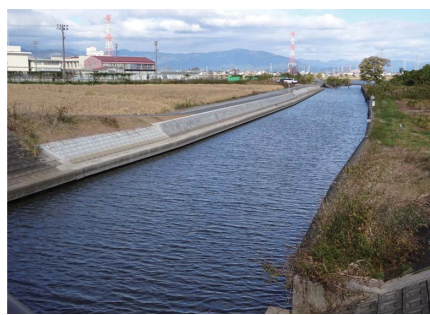
五三川の改修された護岸
