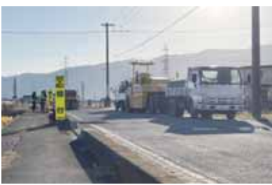
町内道路工事現場
