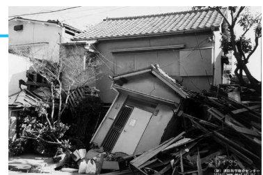
▲ 震災による倒壊家屋
