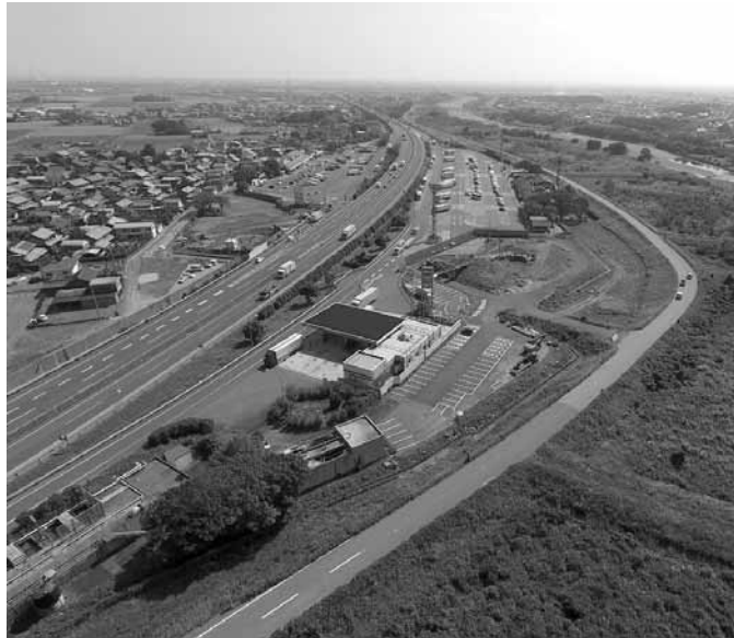
養老SAスマートIC現場
