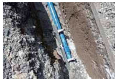
耐震管布設替工事写真
