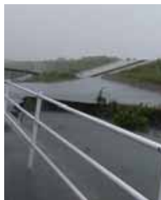
排水機場近くの様子
