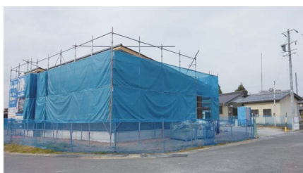
建設中の病児病後児保育施設
