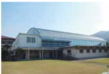
高田中学校屋内運動場
