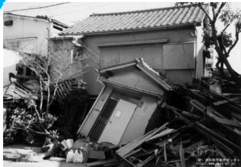
▲震災による倒壊家屋 (出典：(一財)消防防災科学センター)
