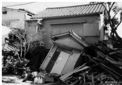
▲震災による倒壊家屋
