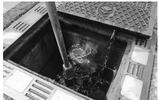
使用中の消火栓
