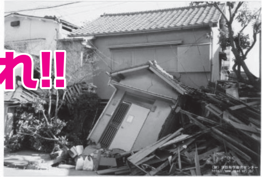
▲震災による倒壊家屋 (出典：(一財)消防防災科学センター)
