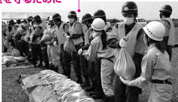
揖斐川右岸堤に完成した揖斐川養老大巻水防拠点(大巻)にて、6月5日(日)に町へ大雨洪水警報(浸水害)が発令されたという想定のもと水防訓練を開催しました。訓練は3班に分かれて土のうを作った後で、堤防の斜面が崩壊した箇所への対応方法である「杭打ち積土のう工法」と、堤防に発生した漏水箇所への対応方法である「月の輪工法」、堤防を越水した場合への対応方法である「積土のう工法」の3工法を実施しました。
