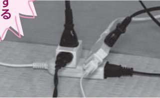
電源プラグとコンセントの間にすき間が生じないようにしっかりと差し込むことで、トラック現象が発生しないよう対策しましょう。
