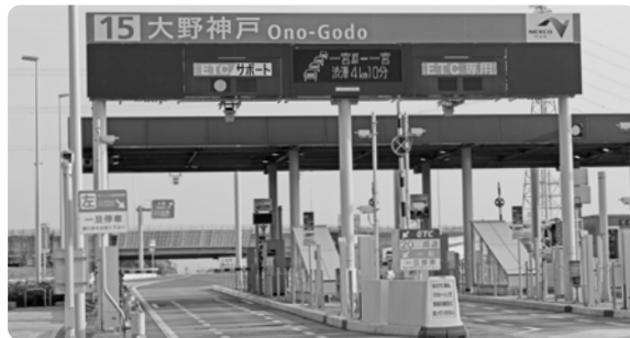
写真は東海環状自動車道 大野神戸IC(例)です
