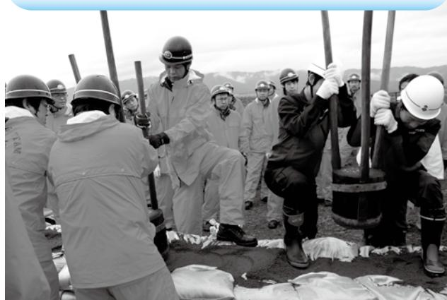
6月9日(日)に揖斐川養老大巻水防拠点(大巻地内揖斐川右岸堤)において水防訓練を実施しました。町へ大雨洪水警報(浸水害)が発令されたという想定のもと、参加者は2つの班に分かれ、各班で土のうを作成した後、堤防に発生した漏水箇所への対応方法である「月の輪工」、堤防を越水した場合への対応方法である「積土のう工」の2工法を実施しました。また、訓練には国土交通省 中部地方整備局の協力により災害対策車両として照明車と排水ポンプ車が派遣され、展示されました。
